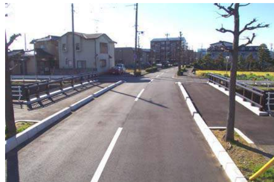
橋面状況 (架替後)
