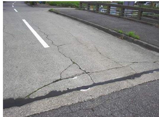
橋面状況 (架替前)
